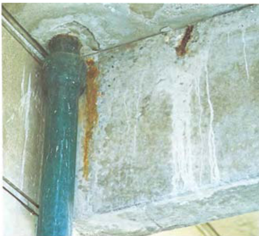
Fig. 1. Vederlag under nedbrydning ved elastisk forsegllet samling.
